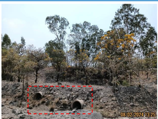
รูปที่ 3-19 ท่อระบายน้ำลงสู่บ่อดักตะกอน
